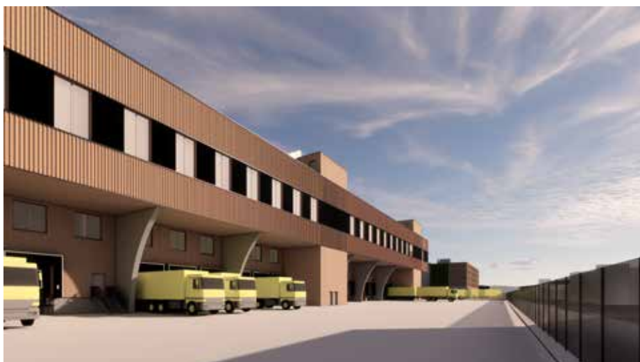
Spatenstich für das neue regionale Paketzentrum der Post in Frauenfeld Bild: Post
