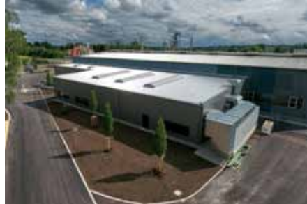
Für das Geschäftsfeld der Lohnreinigung baute die Richard Geiss GmbH am Firmensitz in Offingen eine eigene Halle
