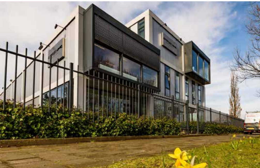
Das neue EFAFLEX Netherlands BV Gebäude: Mit der vollständigen Integration in die EFAFLEX-Gruppe stärkt die niederländische Tochtergesellschaft ihre Marktpresenz und erweitert ihr Serviceangebot Bild:er EFAFLEX
