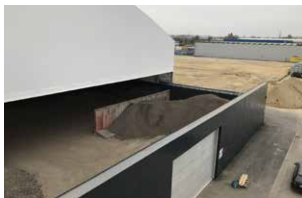
In der offenen Logistikhalle werden nicht gefährliche und gefährliche mineralische Abfälle zwischengelagert und umgeschlagen. Bild: RMS
