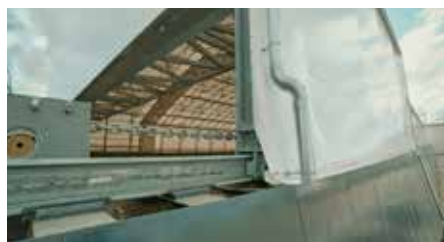
Novum für RUD und RMS: Die Verschiebung eines membranbespannten Dachs. Bild: RUD
