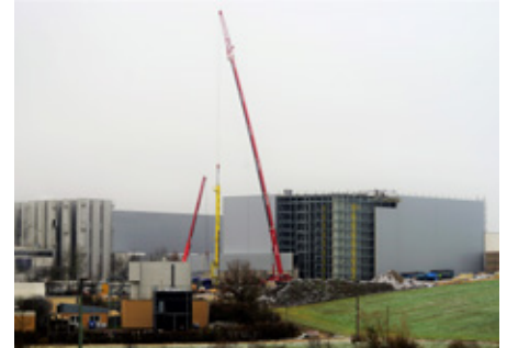
Unmittelbar neben dem bestehenden Hochregallager 3 baute Kardex Mlog ein viertes Hochregallager mit vier Lagergassen, das mit der zugehörigen Fördertechnik in die vorhandenen Strukturen integriert wurde.
