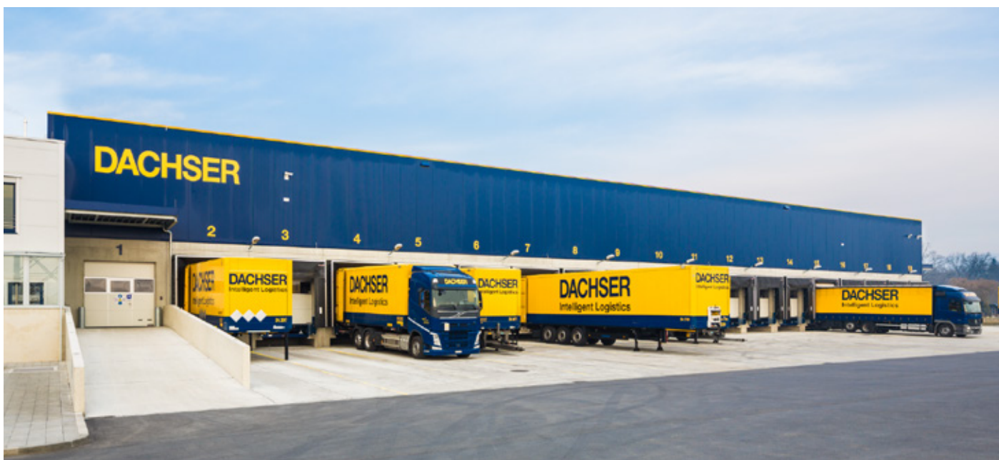
Dachser: eine Partnerschaft mit Weitsicht. Bild: Dachser
