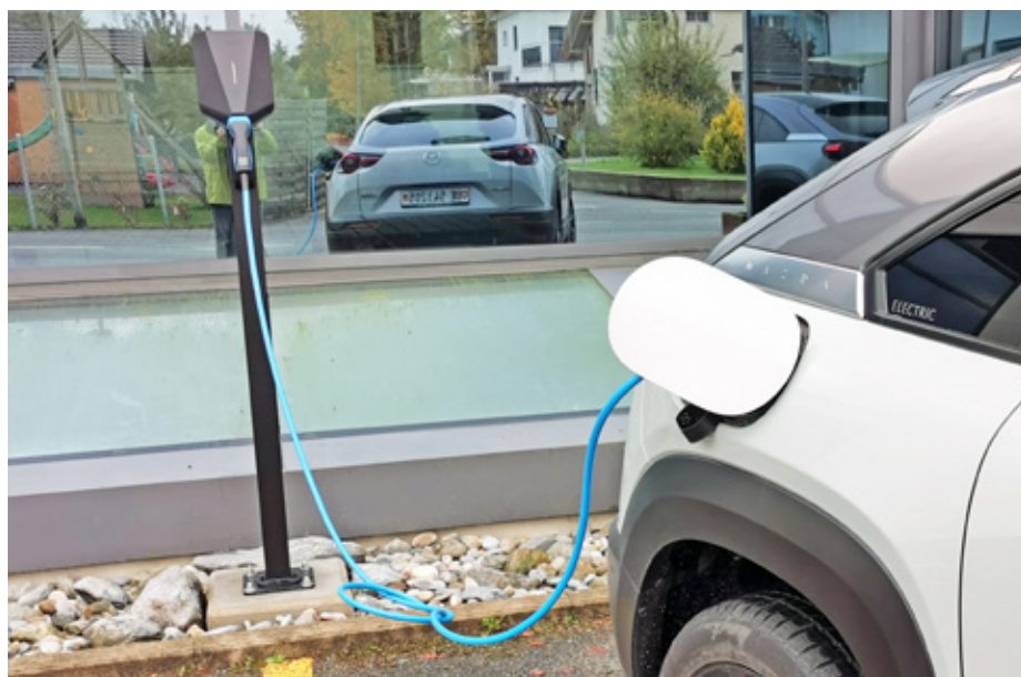
Die Ladesäulen auf den Firmenparkplätzen werden mit Strom von der eigenen Solaranlage versorgt. Bilder: Klaus Vollrath
